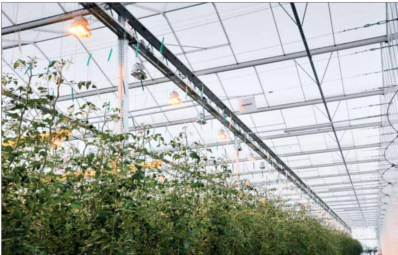
Počas zimy je pre produkciu sladkých rajčín potrebné rastlinám svietiť za pomoci 1000W sodíkových žiaroviek.
